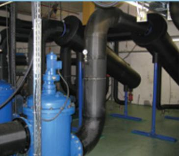
**Usando un Separatore LAKOS come pre-filtro a monte della filtrazione più fine si incrementa l'efficienza e si minimizza la perdita di liquidi.**
